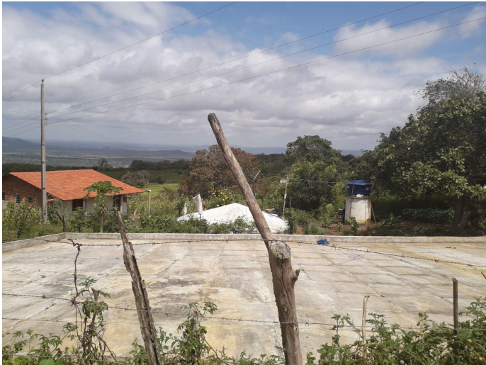
Figura 4 - Cisterna calçadão da comunidade
