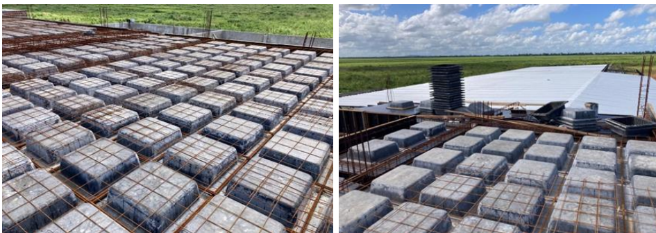
Figura 2: Laje nervurada com o uso de moldes plásticos
