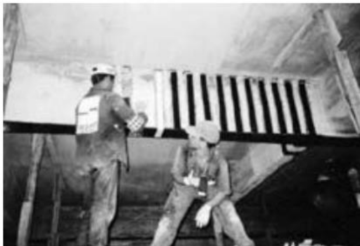
Figura 15: Reforço de viga de concreto à flexão e ao corte
