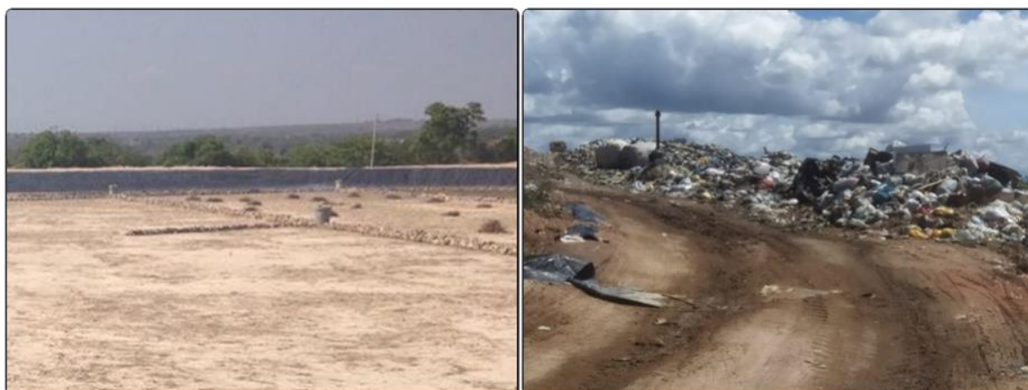
Figura 17 – Drenos de biogás do aterro do CIGRES.
