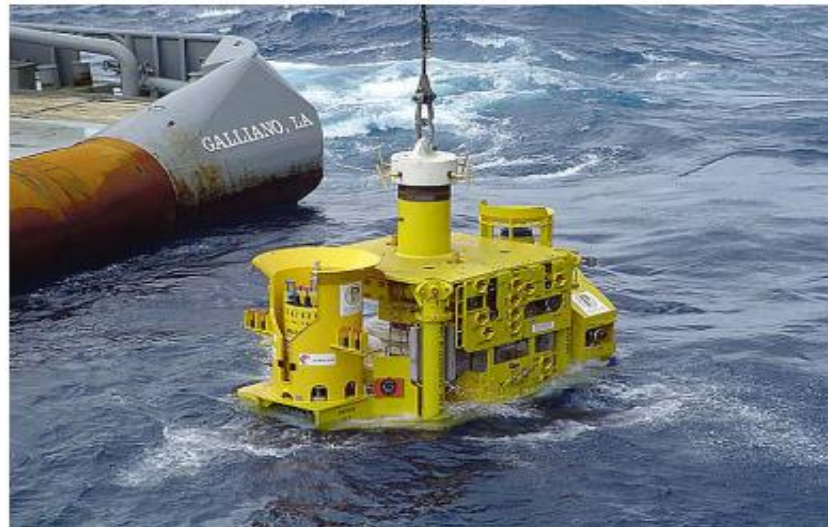
Figura 8: Implantação de uma árvore submarina. Fonte: Yong Bai, 2017.
