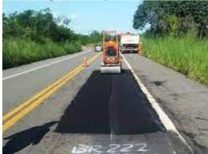
Figura 07 - Execução de um remendo
