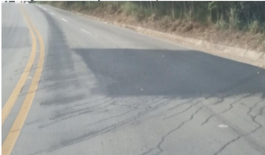
Figura 46 - Marca de pneu com coloração semelhante a remendo
