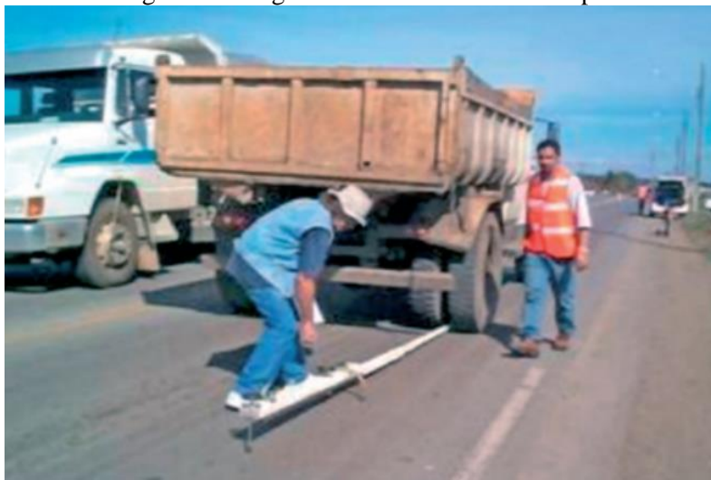
Figura 18 - Viga Benkelman usada em campo
