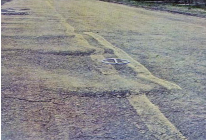
Figura 14 - Ondulações na pista
