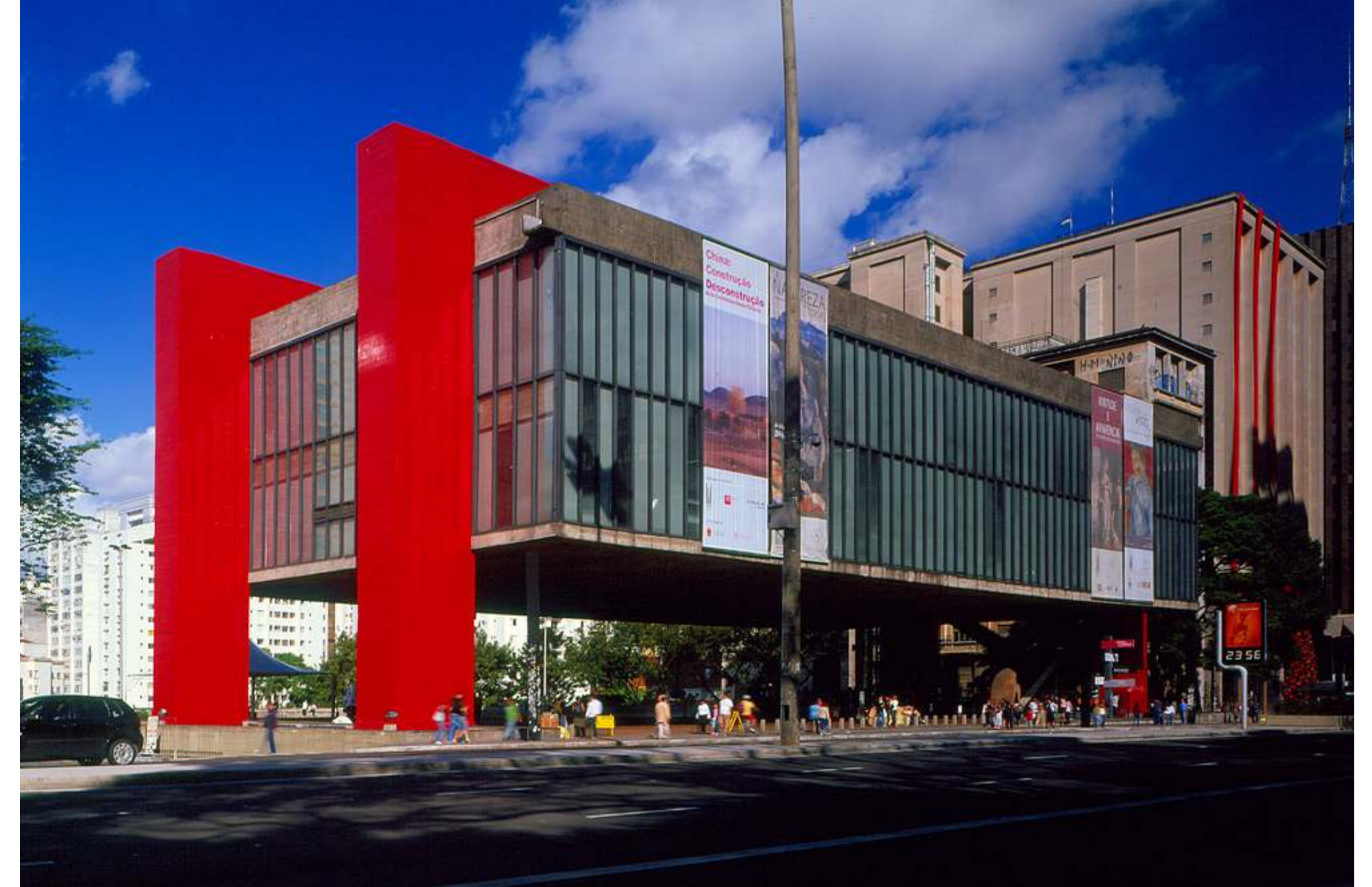
Fig. 28 - Fachada frontal do MASP
