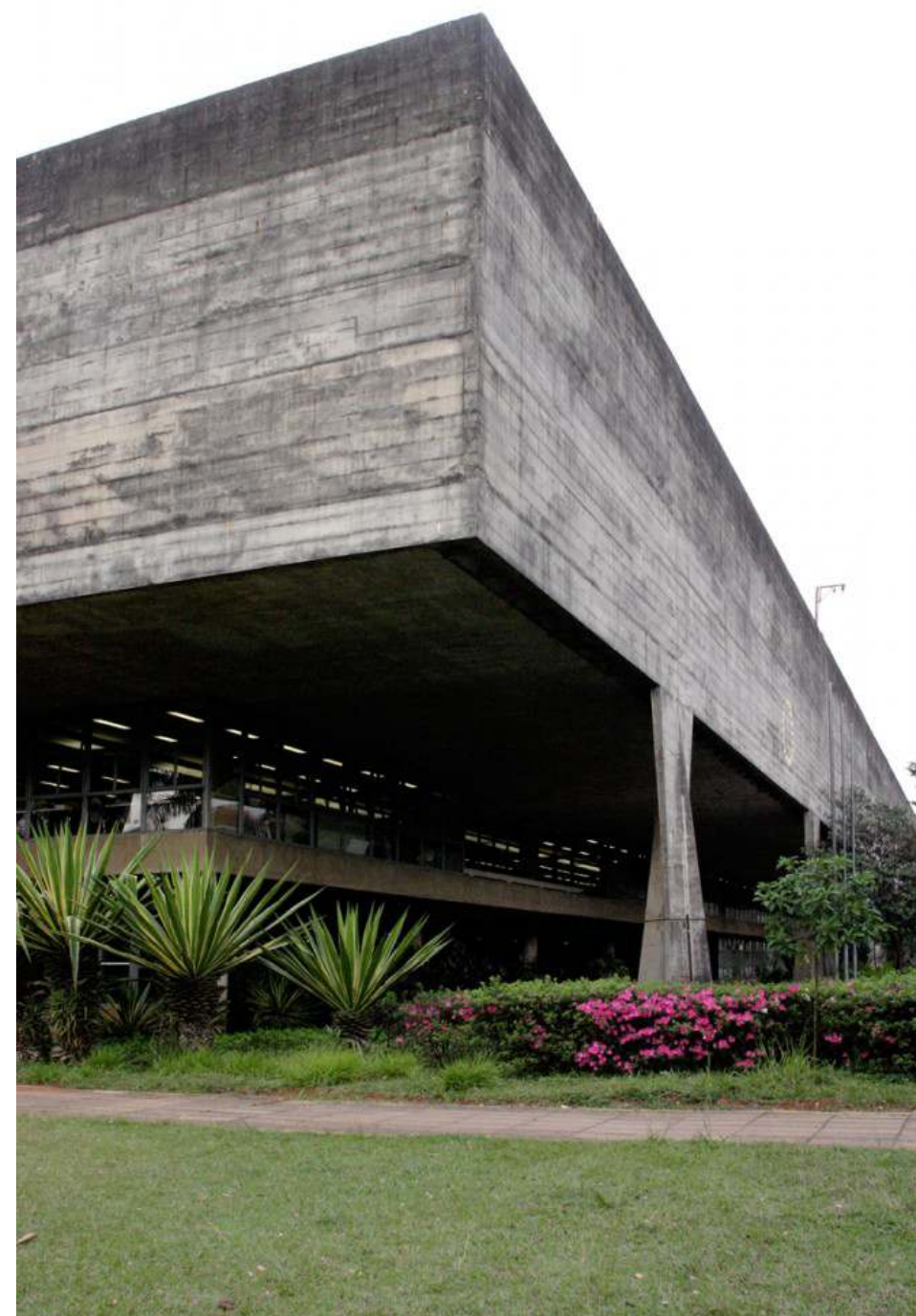
Fig. 39 - Pilar escultural FAU-USA Fonte: Archdaily, 2011.
