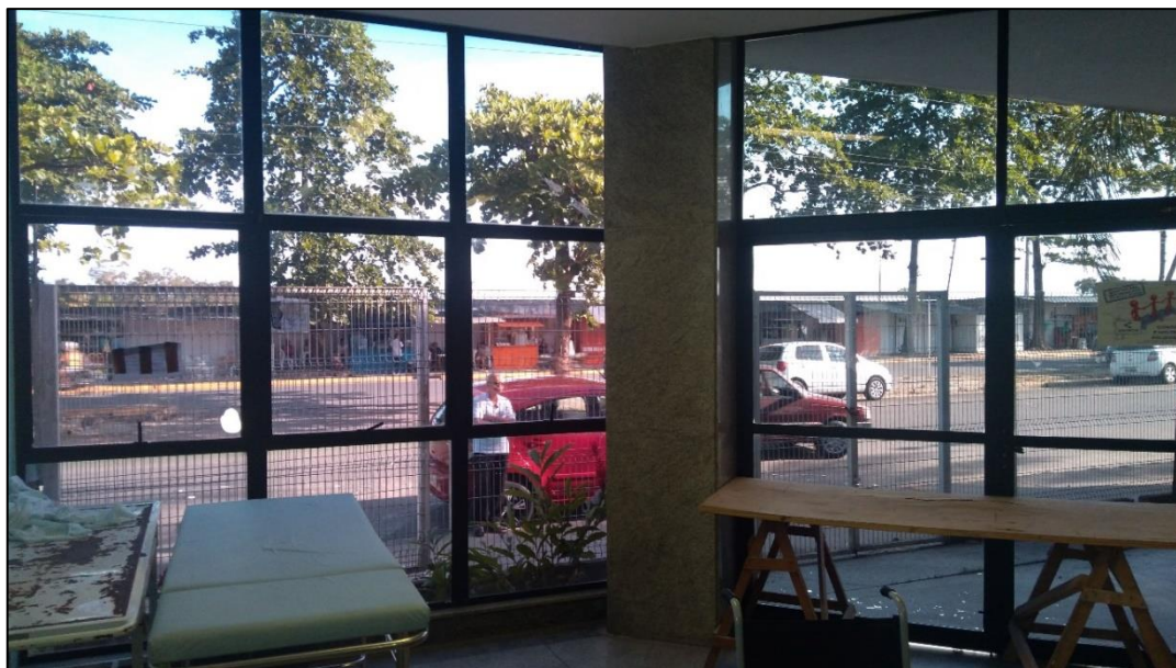
Figura 22- Fachada de vidro da recepção do CACON
