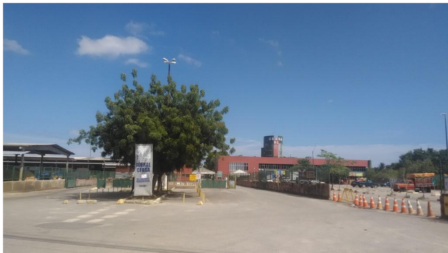
FIGURA 33: Fixo comercial Central Estadual de Abastecimento - CEASA/AL
