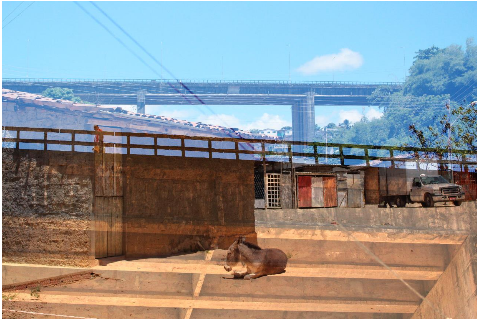
Figura 50: Fotomontagem Ponte Avenida Afrânio Lages que passa suspensa ao Vale do Reginaldo - Maceió/AL. Produzido pela autora, 2019.
