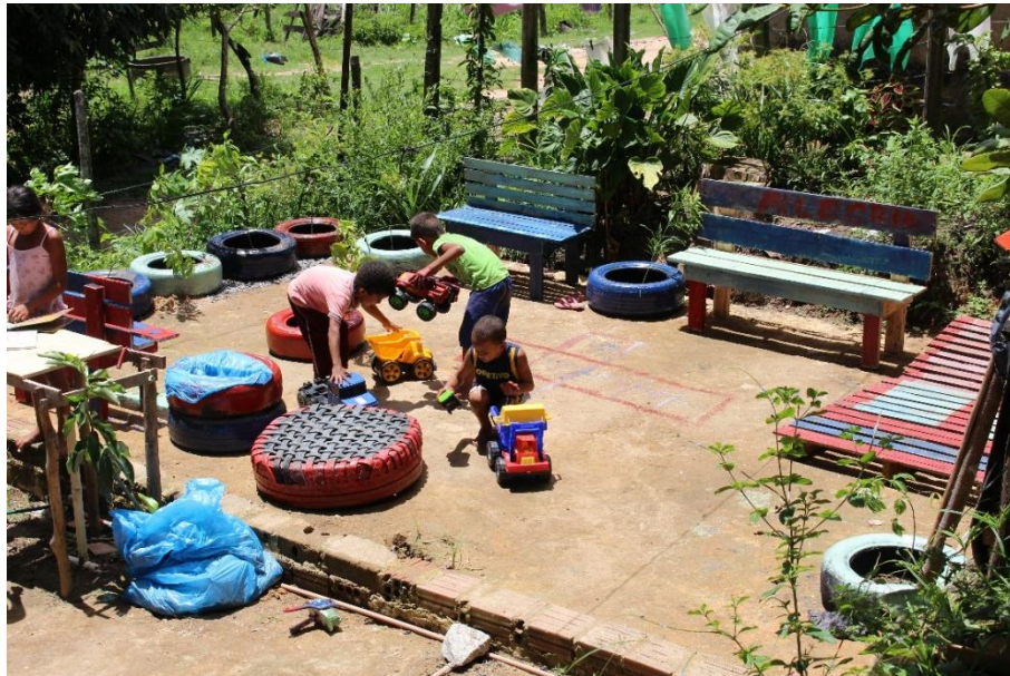
Figura 1: Registro do processo de construção da pracinha na grota da Alegria, Benedito Bentes - Maceió/AL. produzido pela autora, 2018.
